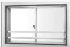
転落防止の手すりの設置
